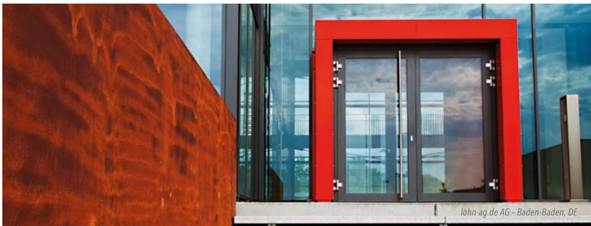
Das Türsystem FRAME<sup>+</sup> 75 DI erfüllt alle Anforderungen an eine hochwertige Eingangstür. Kurze Produktionszeiten und eine effiziente Fertigung zeichnen diese Serie aus. Glatte Falzgeometrien ermöglichen eine einfache Reinigung und einen schnellen Einbau aller Beschlagsvarianten im Falzraum. Die großen Profilkammern bieten Raum zur Aufnahme sämtlicher Beschlagsteile wie z. B. E-Öffner.
