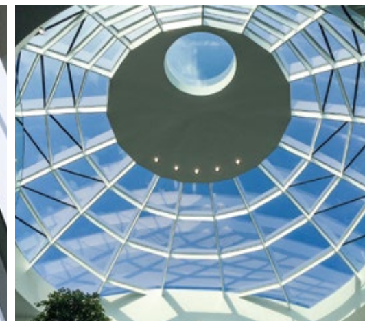
Bürogebäude – Bad Sankt Leonhard, AT
