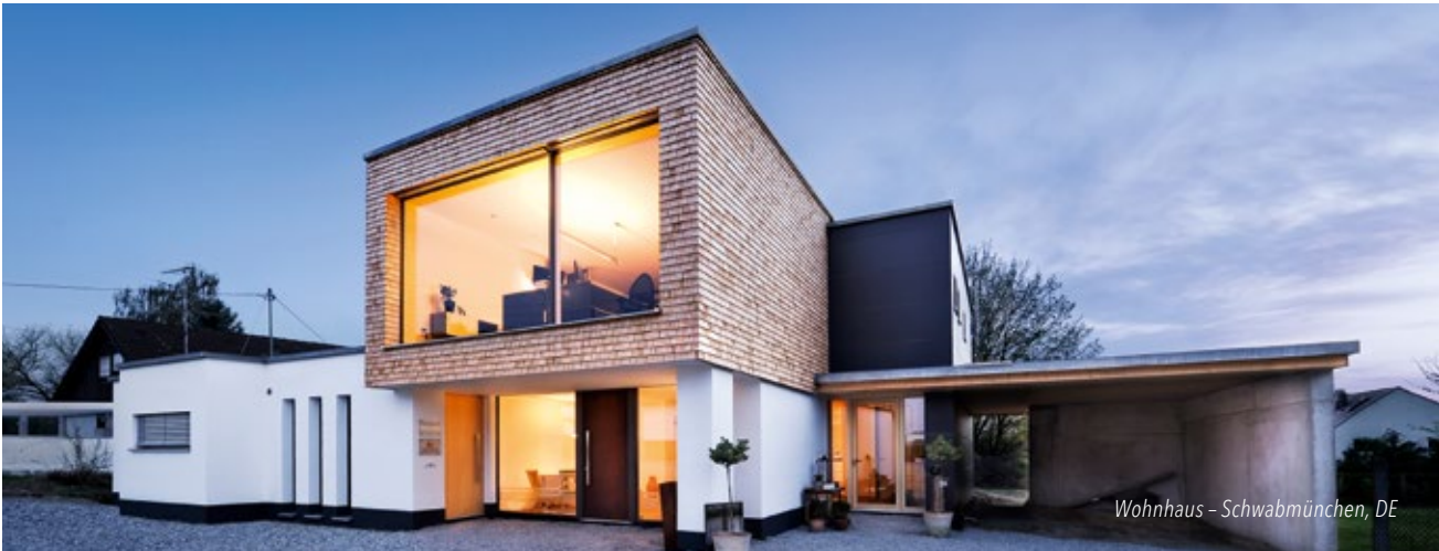
Das THERM + Basissystem lässt sich durch minimale Ergänzungen zur zertifizierten Passivhaus-Fassade aufwerten. Passivhäuser können damit – unabhängig von ihrer Tragkonstruktion – großzügig und wirtschaftlich mit energiegewinnender Festverglasung ausgestattet werden.
