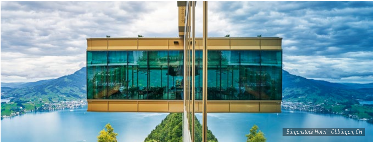
Die THERM + Stahl-Pfosten-Riegel-Fassaden vereinen die Vorteile von Aufsatzkonstruktionen und Fassadensystemen mit integriertem Schraubkanal. Einerseits ermöglicht die Aufsatztechnik die freie Wahl beim Einsatz von handelsüblichen Stahlprofilen und andererseits gewährleistet die spezielle Aufsatzkonstruktion einen optimalen Korrosionsschutz.
