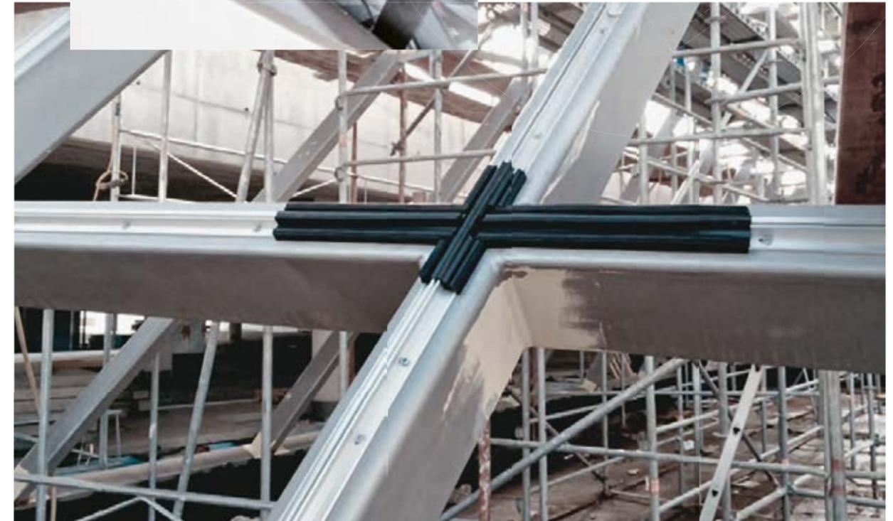
GRUNDPROFIL DES FASSADENSYSTEMS THERM<sup>+</sup> H-I AUF STAHL-UNTERKONSTRUKTION
