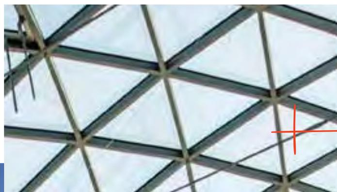
DAS 12 TONNEN SCHWERE ALUMINIUM-GLAS-KUPPELDACH VERBINDET AUF ELEGANTE WEISE DAS ALTE UND NEUE GEBÄUDE DER SPARKASSE IN POTSDAM. EINE INNOVATIVE LÖSUNG, BEI DER 228 DREIECKIGE GLASELEMENTE UND 360 SPARREN ZUM EINSATZ KAMEN.
