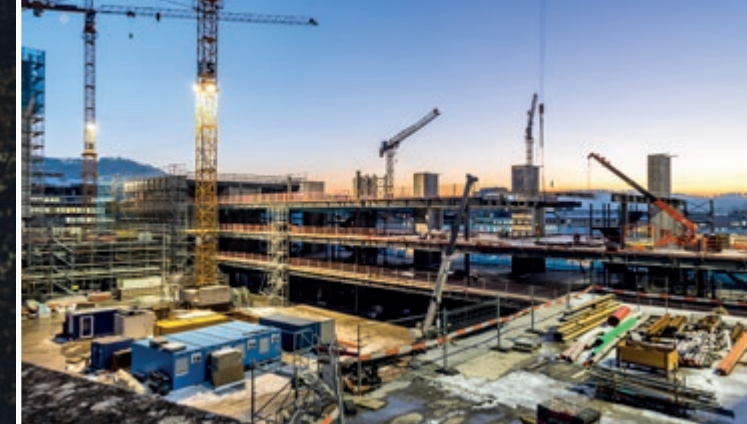
MÉGATENDANCE #3 TEMPS DE CONSTRUCTION
