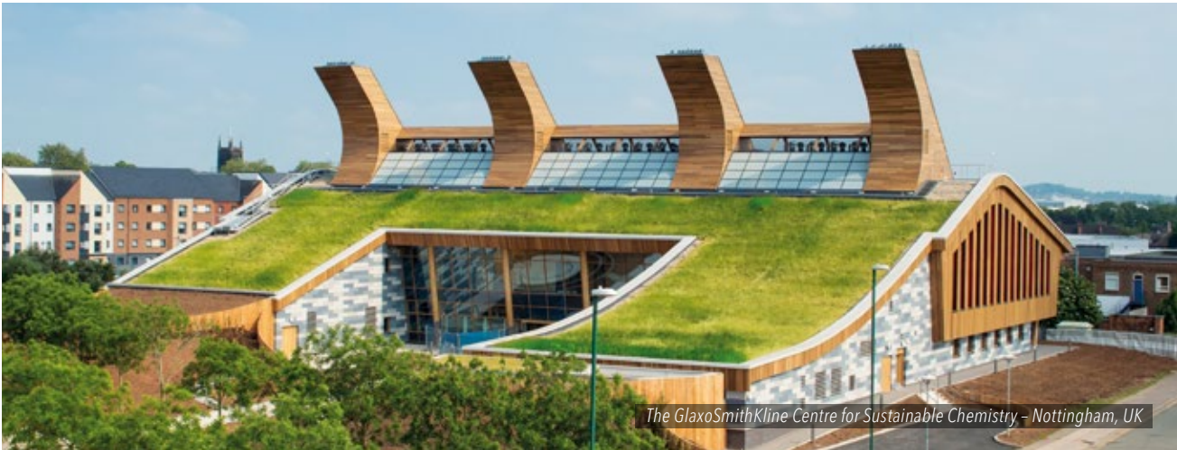
Les murs-rideaux bois THERM + présentent un système de vitrage éprouvé pouvant s'adapter sur tous les types d'ossatures secondaires en bois à partir d'une largeur de 50 mm. La technique du système, homologuée par l'avis technique français, sépare de manière conséquente et fiable la partie design en bois des éléments fonctionnels en aluminium et EPDM.
