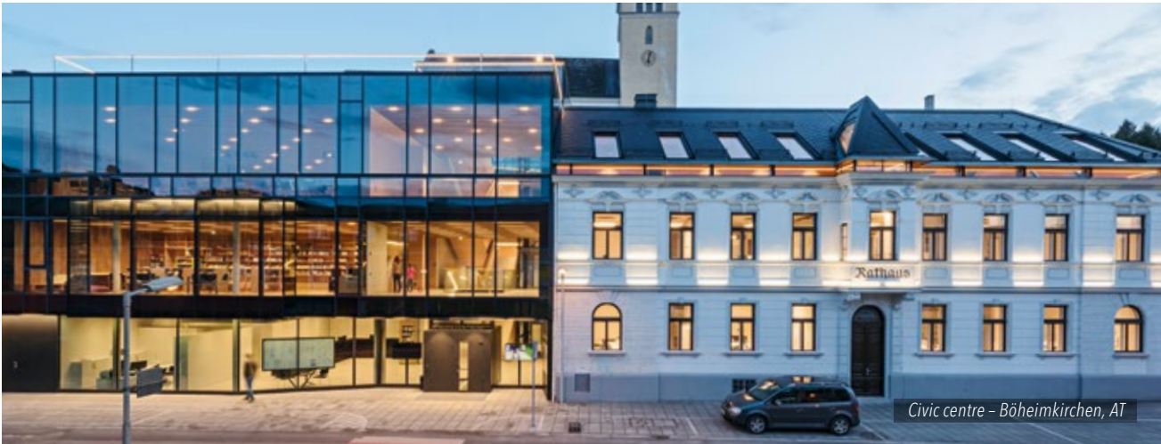
Grâce au système de façade THERM + FS-I, vous assemblez directement le profilé serreur de la façade vitrée à l'ossature porteuse en acier – sans avoir à souder au préalable. Le canal à visser intégré au profilé porteur le permet.
