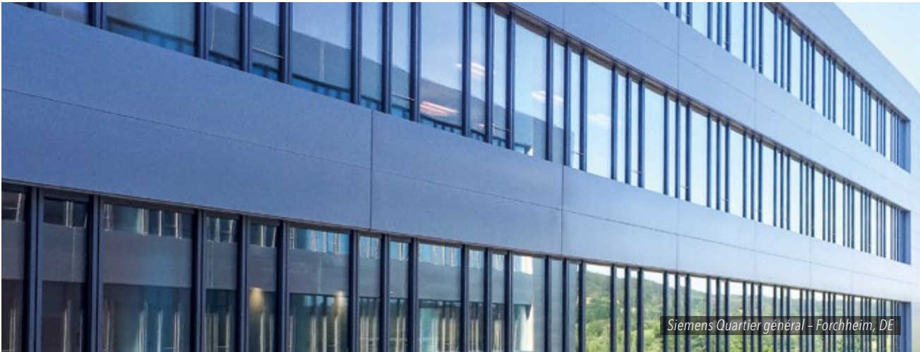
Le système FRAME + 75 WA en version ouvrant vers l'extérieur est disponible en variantes à l'anglaise, à soufflet, à l'italienne avec et sans compas.
