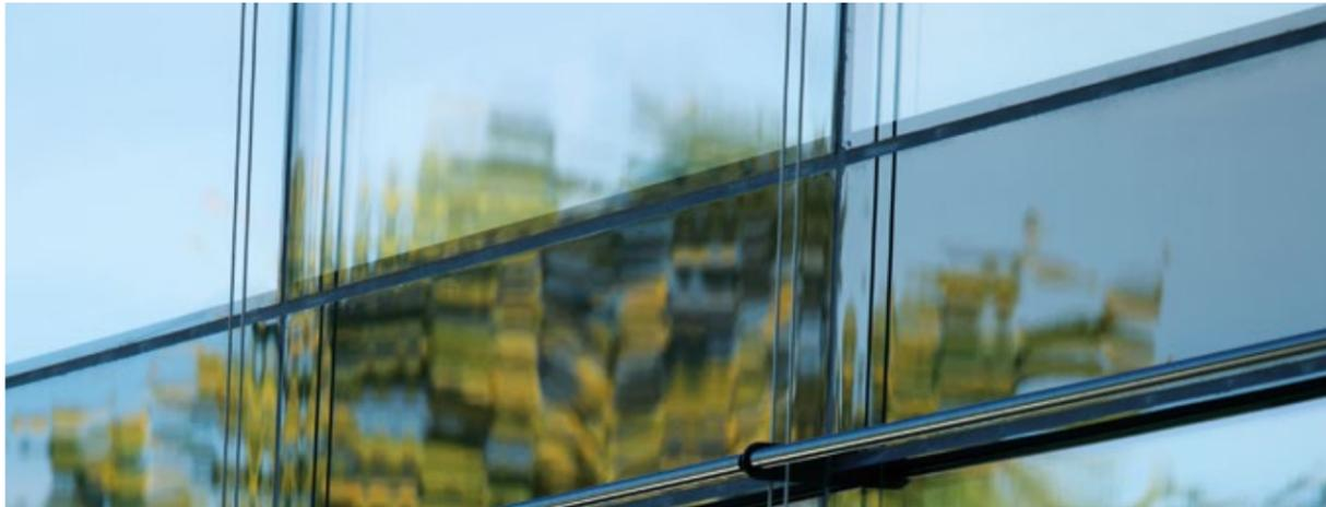
Les façades structurales THERM<sup>+</sup> Structural Glazing SG2 (VEC) utilisent la technique de vitrage la plus filigrane. Seul un joint étroit en silicone reste visible entre les verres isolants. La fixation du verre intérieur s'effectue de manière simple, rapide et sûre grâce à des pièces de fixation SG spéciales à serrer. Grâce au système d'isolation par blocs isolants SG, ces façades atteignent des valeurs d'isolation thermique exceptionnelles.
