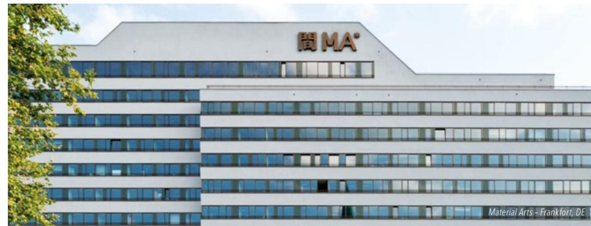
Dans sa variante comme système de façades vitrées FRAME<sup>+</sup> 75 FF, cette technologie tournée vers l'avenir peut être mise en valeur avec des montants-traverses à l'apparence mince avec des largeurs apparentes de seulement 50 mm.
