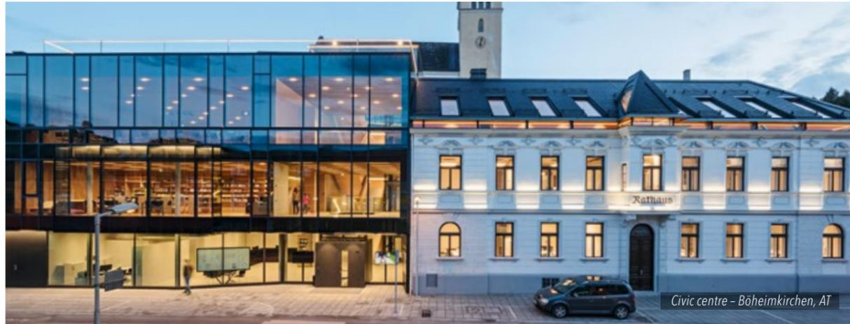
Grâce au système de façade THERM<sup>+</sup> FS-I, vous assemblez directement le profilé serreur de la façade vitrée à l'ossature porteuse en acier – sans avoir à souder au préalable. Le canal à visser intégré au profilé porteur le permet.
