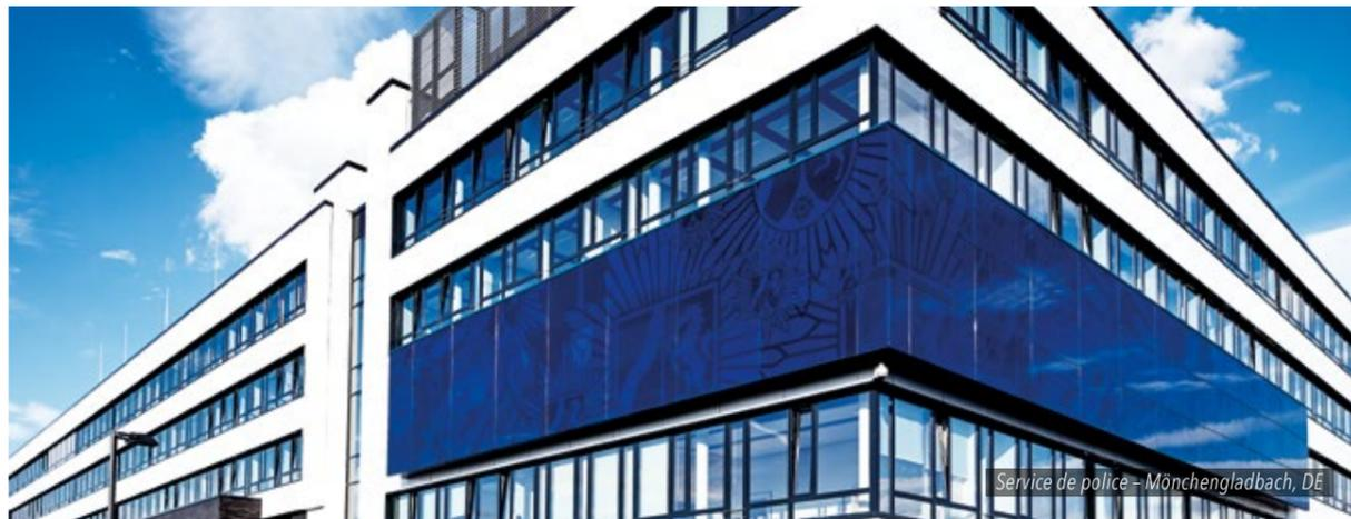
La conception innovante du système FRAME<sup>+</sup> avec structure modulaire : le profilé du système se compose de demi-profilés intérieur et extérieur identiques en aluminium et s'adapte à la profondeur d'encastrement et à l'isolation thermique avec les baguettes isolantes THERMORIT.
