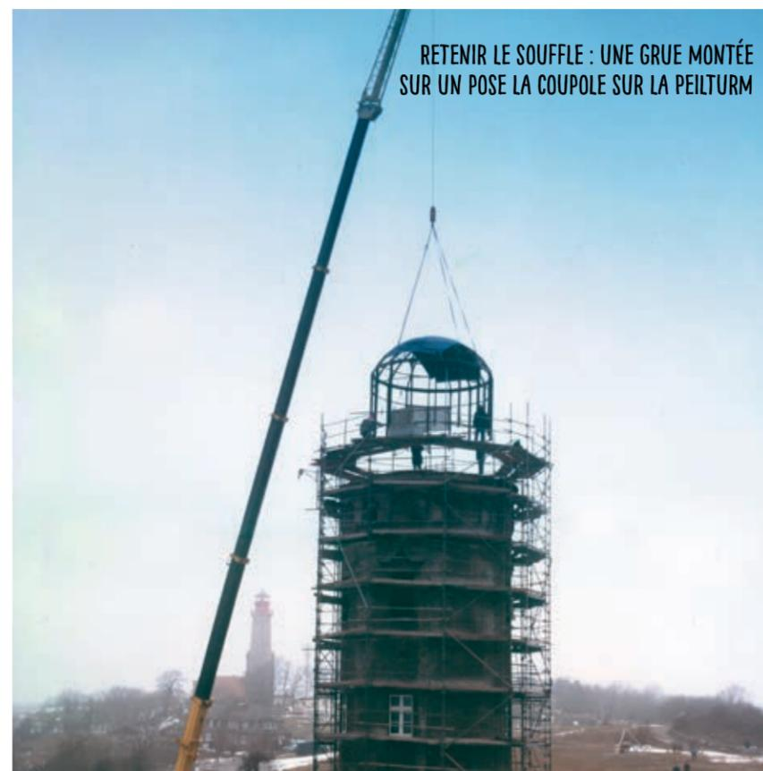
RETENIR LE SOUFFLE : UNE GRUE MONTÉE SUR UN POSE LA COUPOLE SUR LA PEILTURM
